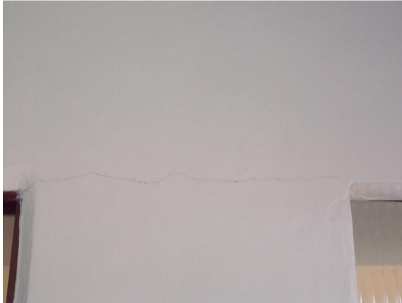
Figura 03 – Fissura horizontal
